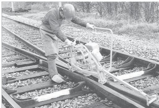
*Рис. 4.12. Рейкошліфувальний верстат для шліфування хрестовин*
