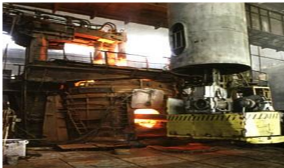
Рис.6.11.5. Електродугова піч ДСП - 50 і завантажувальна машина (загальний вигляд)
