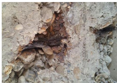
Рис.18.1. Корозія бетону
