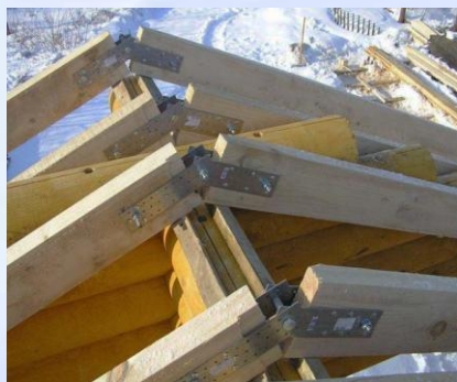
Вузол спирання крокв на гребеневий прогін
